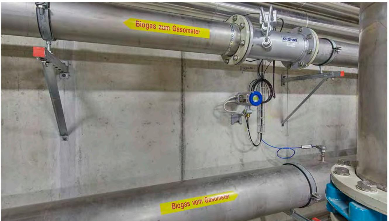
Durchflussmessung von Biogas mit Optisonic 7300W
