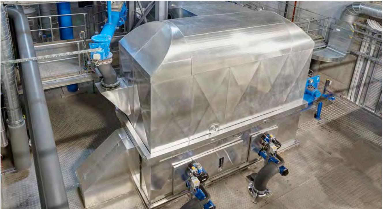
Oberteil Wirbelschichttrockner mit Schlammeinträgen
