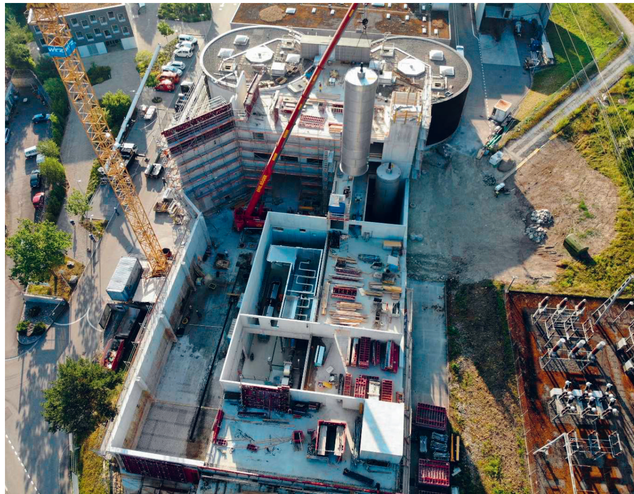
Juli 2019, Einheben der Substratspeicher
